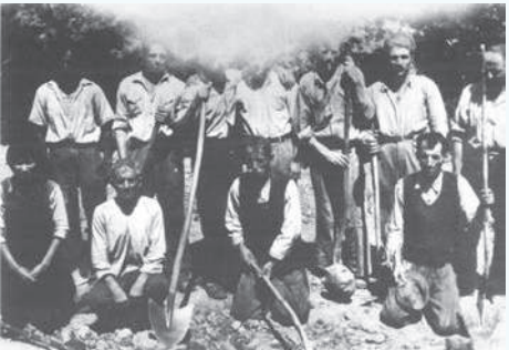
Από την κατασκευή του αμαξιτού δρόμου στο Δίστρατο – Φτέρη περί το 1950 που συνδέει με την Άρτα.
