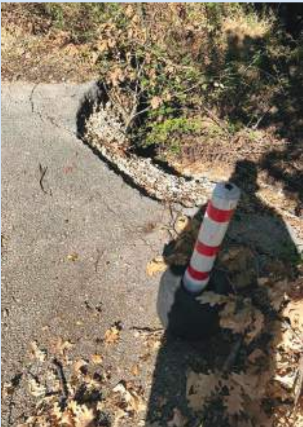
Καθίζηση - τομή οδοστρώματος στη σύνδεση του δικτύου με το πιεστικό συγκρότημα
