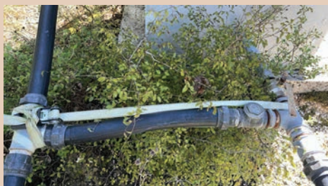
Σύνδεση πιεστικού και στήριξη με μάντα!
