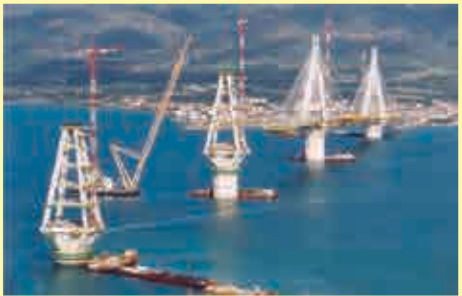
2. Γέφυρα Ρίου - Αντιρρίου από την κατασκευή
