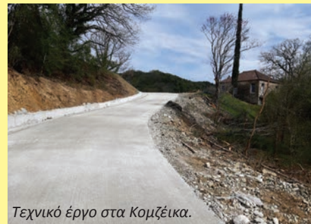
Τεχνικό έργο στα Κομζέικα. Ακόμα και ο σκύλος χάρηκε τον δρόμο.
