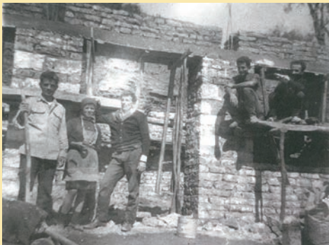
Κατασκευή σπιτιού στο Δίστρατο τη δεκαετία του 60
