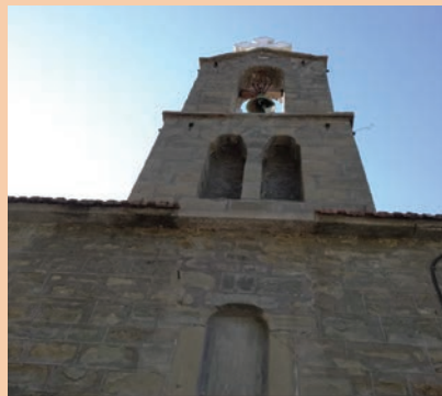
Στο καμπαναριό, εκτός της επισκευής έγινε και εγκατάσταση ηλεκτρικής σήμανσης
