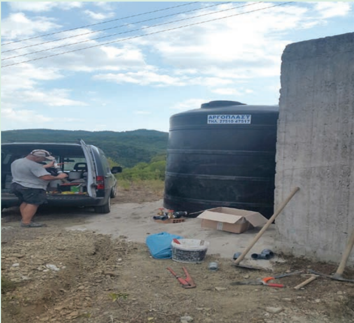
Τοποθέτηση πλαστικής δεξαμενής 10 κυβικών μέτρων δίπλα από την τσιμεντένια για το νερό της γεώτρησης
