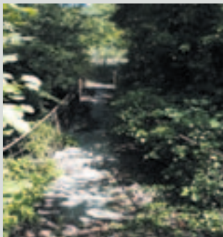
Πεζογέφυρα στα Αναστασοπουλείικα
