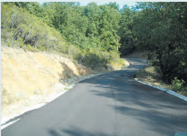
Φωτογραφία από τον φρεσκοστρωμένο δρόμο Κρουονερίου - Ναζαίων. Καλορίζκος!
