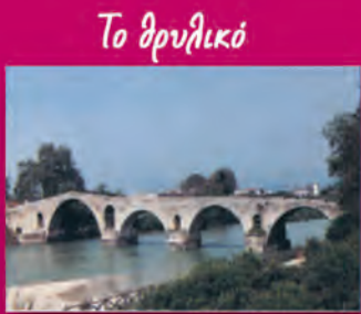
Γέφυρα της Άρτας
