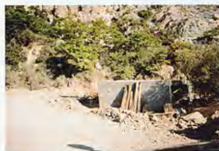
Γεφυρώθηκε η Αχυβάδα στο «ΧΑΒΟ» της Ροδαυγής με κατασκευή τεχνικού έργου σχήματος π.
