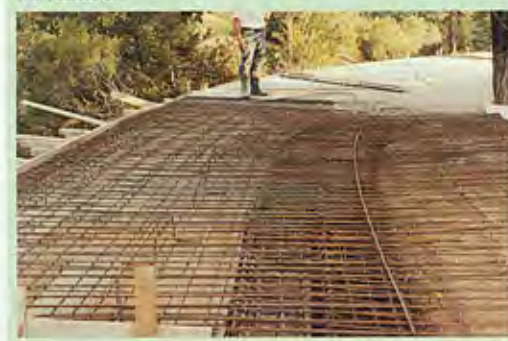
Στημιότυπο από τις εργασίες επέκτασης - διαμόρφωσης της πλατείας (κυκλικός πρόβολος). Εδώ φαίνεται τμήμα από το σιδηρό οπλισμό έτοιμο για μπετό.
