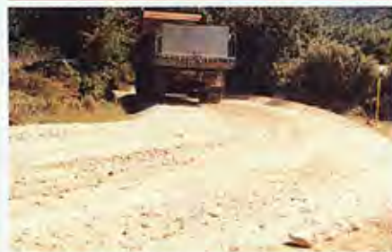
Προετοιμασία του οδοστρώματος με καταβρεχτήρα για να ακολουθήσει η συμπίεση. Κάπως έτσι... γίνονται τα έργα. Μπράβο!
