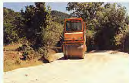
Συμπύεση μέχρι αρνήσεως του 3Α Λατομείου με οδοστρώτηρα. Ο δρόμος έτοιμος για ασφαλτόστρωση.
