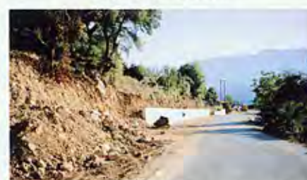
Τοίχος αντιστήριξης στο δρόμο Ροδαυγής - Σκούπας. Στημιότυπο από τις εργασίες διαπλάτυνσης του δρόμου.
