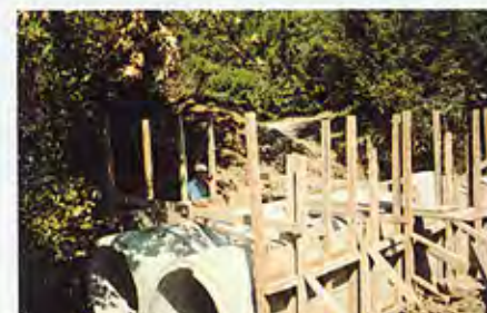
Καλούπια για τον κιβωτισμό με μπετόν του δίδυμου σωληνωτού... (Μεταξύ μας: Θέλει ακόμη 3 σωλήνες του 1 μέτρου x2)
