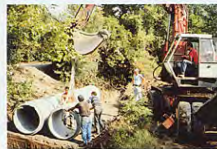
Η μεγάλη στιγμή έφτασε: Ο Γερανός τοποθετεί τις σωλήνες για τη γεφύρωση του ρέματος στη θέση ΚΟΜΤΖΙΑ που χώριζε στα δύο τον οικισμό! (Παν. Σκαλτσογιάννης: Η φιλοσοφία του Δήμου είναι να μην υπάρχει ούτε μία ΑΧΥΒΑΔΑ!
