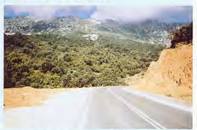
Μετά τη Γέφυρα ΤΖΑΡΗ προς Ξεροβούνι. Φωτο Χρ. Αντωνίου
