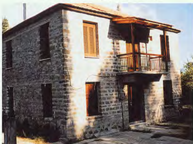
Το παραδοσιακό πέτρινο σπίτι του αείμνηστου χτίστη Κων/νου Ζαχαρή (από τη Φτέρη). Ιδιοκτησία σήμερα της κόρης του Ευγενίας Κωσταβασιλή-Ζαχαρή. Το ισόγειο στη δεκαετία του 1950 λειτουργούσε σαν καφενείο. Χτίστηκε το 1945 από τον ίδιο κ.λπ.
