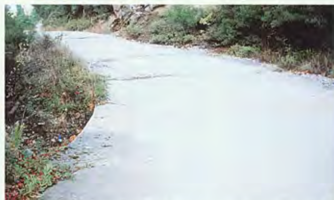
Ο δρόμος προς τα ΛΑΓΚΑΔΙΑ περνάει μέσα από Αχυβάδες. Το χειμώνα είναι αδιάβατος! Απαιτείται άμεσα τεχνητό έργο με σωληνωτά.
