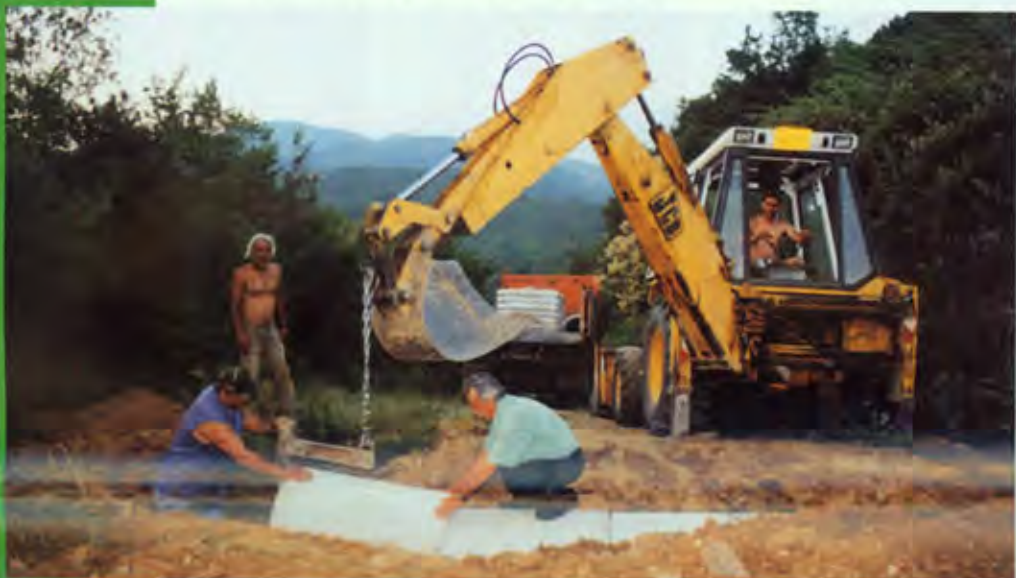
Τοποθέτηση σωληνωτών (περιοχή Αικ. Καπρούτσου) 06/04/2004 στα ΛΑΓΚΑΔΙΑ
