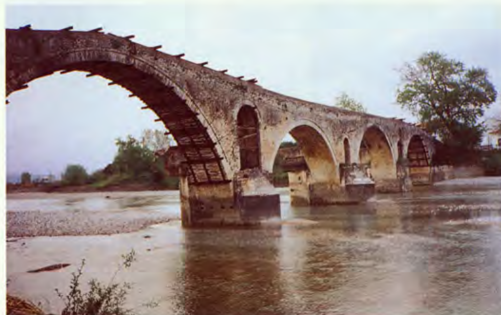
Παλιά φωτό από τις εργασίες επισκευής του Γεφυριού.
