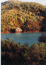
Η λίμνη του Αραχθού από το φράγμα Πουρναρίου.
