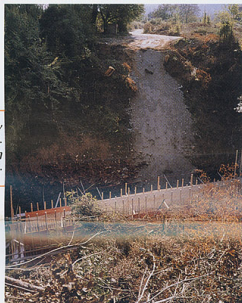
Κατασκευή τοιχείων για μπετό. Γεφύρωση του ρέματος...
