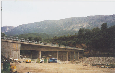
Ολοκληρωμένη πλέον η γέφυρα. Διακρίνονται τα 7 βάθρα (2 Ακρόβαθρα και 5 μεσαίοι) και τα σθιβάδια ασφαλείας.
