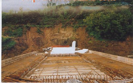
Αεροπρόερα κατασκευής της γέφυρας (αδερφός σπλιάρης)
