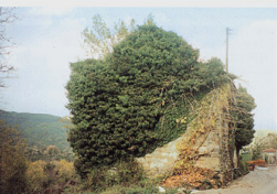
Η εγκατάλειψη είναι εμφανής...
