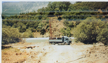
Η ακριβής θέση της γέφυρας, όπου έγιναν και οι γεωτρήσεις.
