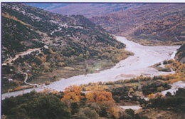
Μεσοχώρι. Το τμήμα του δρόμου που βρίσκεται υπό κατασκευή
