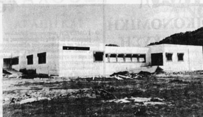
ΚΕΝΤΡΟ ΥΓΕΙΑΣ ΥΠΟ ΚΑΤΑΣΚΕΥΗ
